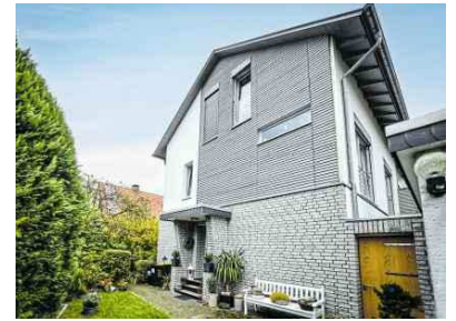
Die Fassadenverkleidung aus lichtgrau lasiertem Lärchenholz lehnt sich pfiffig an die Klinkerung des alten, unteren Hausteils an.
