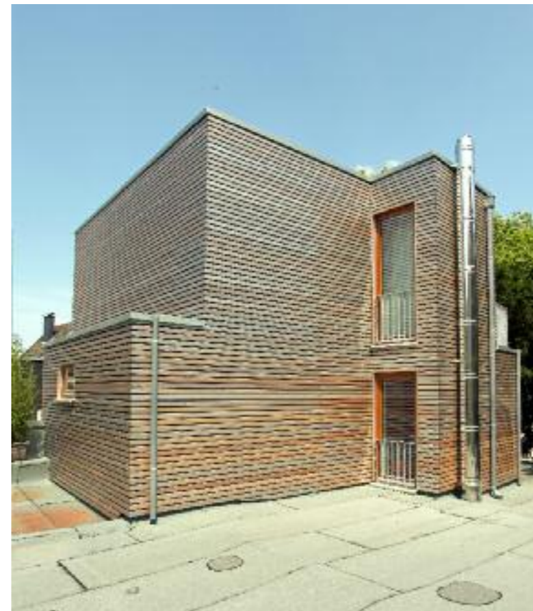
Gegenüber dem ausladenden Erdgeschoss sind die zwei neuen Geschosse in Holzrahmenbauweise auffallend bescheiden.
