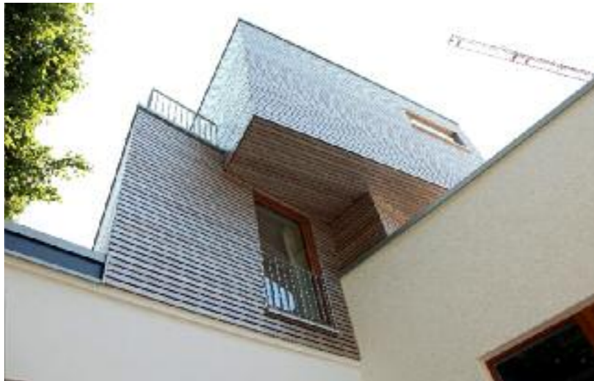
Die Aufstockung zeigt sich nach außen in heller, lasierter Eiche und setzt sich damit kontrastreich vom „Rest“ des Ensembles ab.
