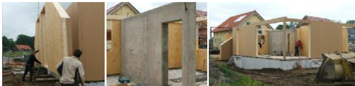
Aufbau der Erdgeschosswände in Holzrahmenbau. In der Mitte des Hauses ist die Betonwand gut zu erkennen (siehe Kasten „Bauteilaktivierung“).
