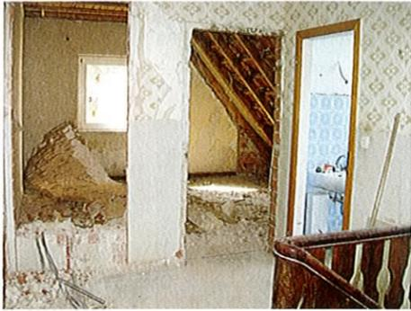
Die Sparren mussten aufgedoppelt werden, damit eine ausreichend dicke Dämmschicht in die Zwischenräume passte. Rolf/Stüwe
