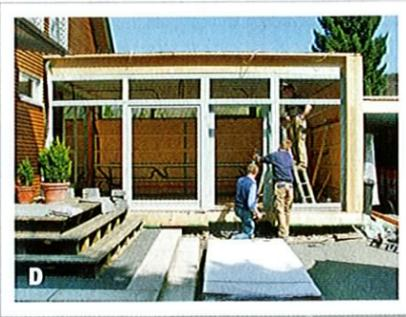
**Bauphase Anbau A** Ein Streifenfundament bildet die Grundlage für den Anbau **B** Auch die Grundplatte besteht aus einer Holzrahmenkonstruktion. Diese liegt auf einem Stahlträger **C** Ein Rahmen besteht aus senkrechten Ständern und Querhölzern. Holzwerkstoff-Beplankungen stabilisieren die Wand **D** Nordlicht scheint durch die komplett aus Fensterelementen bestehende Fassade
