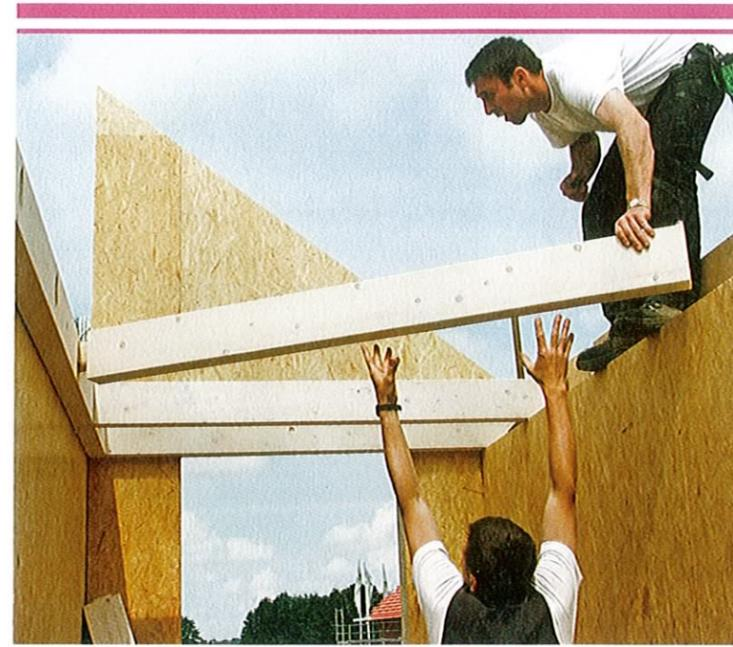
Bilder aus der Bauphase: Eine örtliche Zimmerei erstellte den Rohbau in Holzrahmenbauweise. Gut zu erkennen auch die Betonwand auf der Fundamentplatte, die als interner Wärmespeicher dient.
