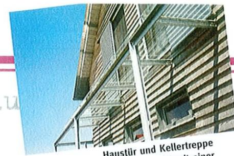
Haustür und Kellertreppe sind überdacht mit einer verzinkten Stahlkonstruktion mit Stahlseilsystem und aufgelegtem Sicherheitsglas.
