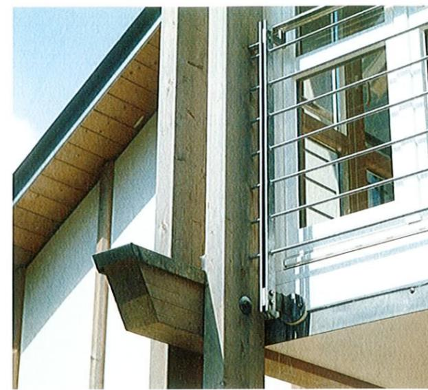
Details der Holzrahmenkonstruktion in Verbindung mit dem Stahlgeländer vor den Fenstertüren.
