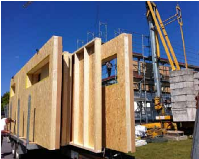
Die fertigen Holzwandelemente sind zur Baustelle gebracht und direkt verbaut worden. So verkürzte sich die Bauzeit erheblich.
