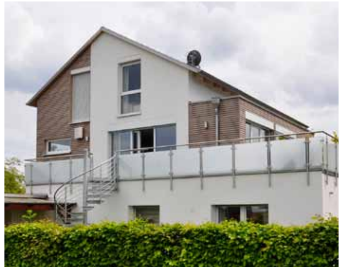
Die Rückansicht des Hauses: Mehr als 20 m 2 Dachterrasse stehen der Familie oben zur Verfügung. Über die Treppe gelangen sie direkt in den Garten.
