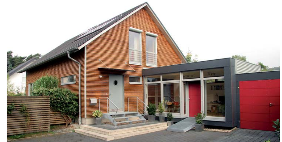
Überzeugend: Architektur steht nicht gegen Energieeffizienz. Die Konstruktion in Holzrahmenbauweise – mit einer Außenverkleidung aus Lärchenholz, ausgeführt von der General Energie GmbH, und Aluminiumprofileinfassung – überzeugt durch ihre extrem gute Dämmung.
