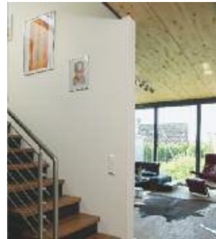
Holz herrscht vor: Die hoch tragfähigen Brettstapeldecken, die noch dazu gute Schallschlucker sind, wurden lediglich transparent lasiert.
