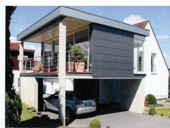
Zeit- und Kostenaufwand halten sich gut in Grenzen: Über den wenigen Sichtbetontafeln konnte das Obergeschoss als vorgefertigte Holzrahmenkonstruktion mit schlichtem Flachdach zügig aufgerichtet werden.
